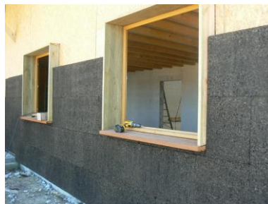
b) Travaux d'isolation extérieure d'une maison
