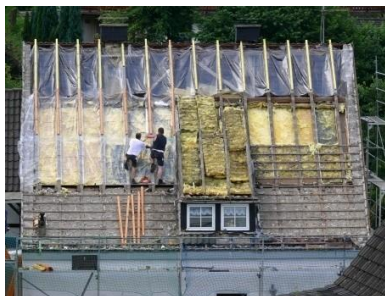
a) Travaux d'isolation extérieure d'une maison
